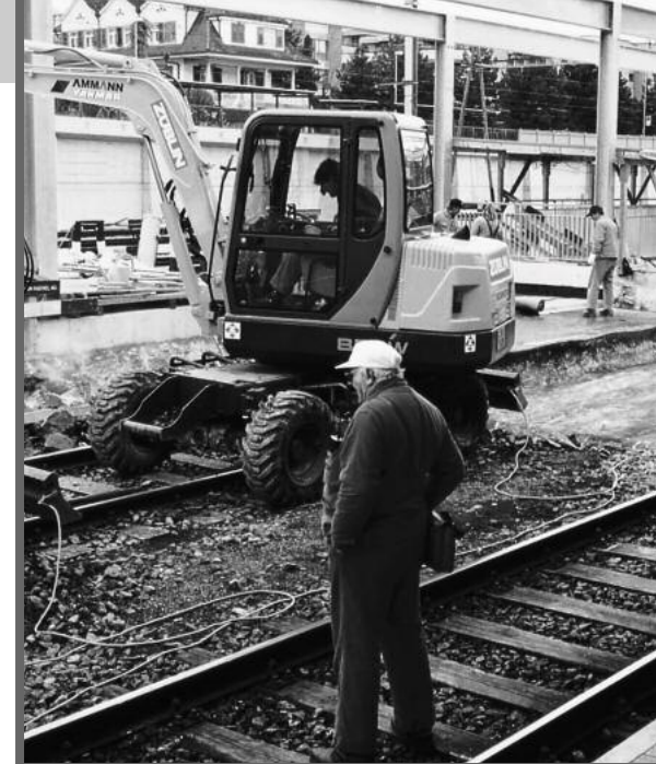
Streng bewachte (Bau-) Züge
