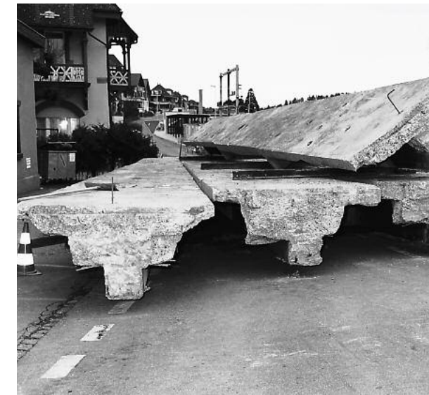
Die alte Niesenbrücke ist zum Abtransport bereit
