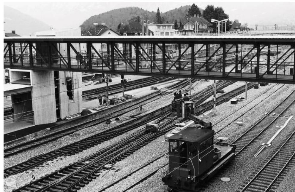
Logenplatz für Zuschauer auf der neuen Passerelle
