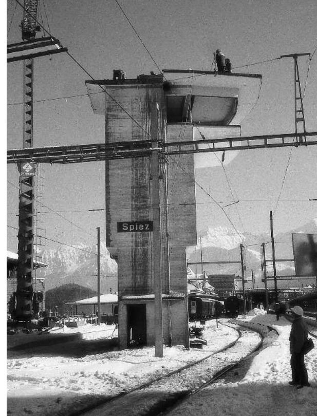
Das alte Stellwerkgebäude wird portioniert und «ausgeflogen».
