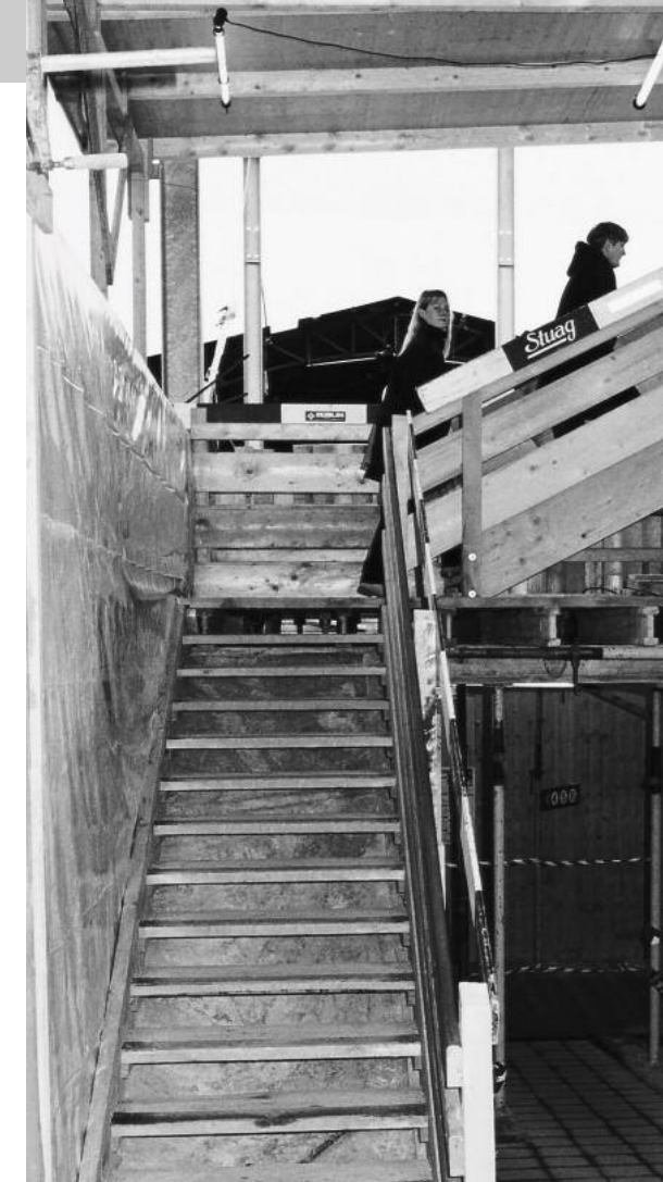
Der Weg zu einem neuen Bahnhof führt über Baustellen und Provisorien
