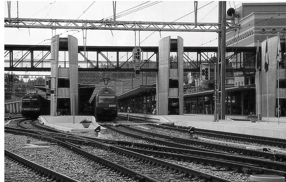
Der «Verkehrsfluss» umbracket die pfeilerähnlichen Treppenhäuser der Passerelle
